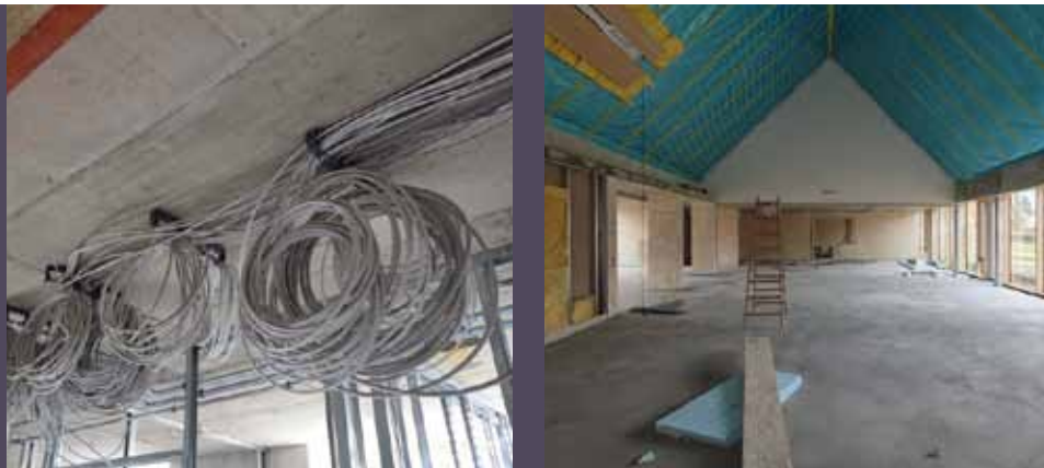
In unserem Gemeindehaus wurden hunderte Meter Kabel verlegt (l.) und das Dach nach neuesten energetischen Standards gedämmt (r.)
