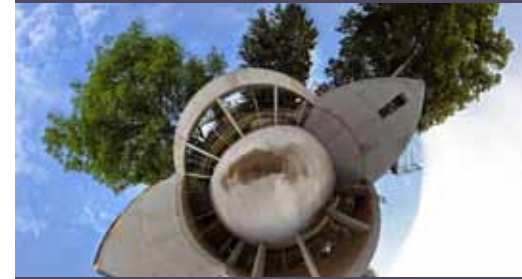
Panoramabild der Gemeindehaus-Baustelle
