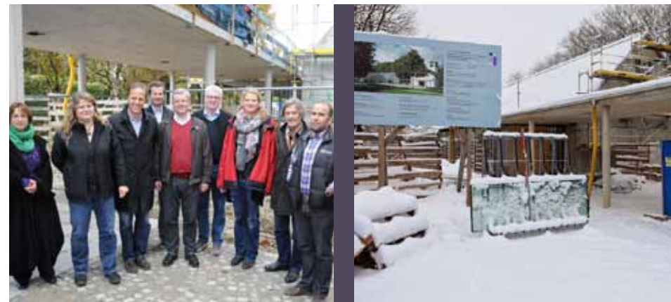
Richtfest Ende September 2014 mit den Bauleuten und die verschneite Baustelle im Dezember 2014, vom Kirchenvorplatz aus gesehen
