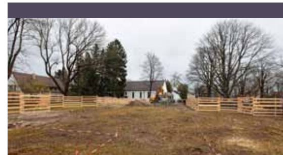
Vorbereitung des Baugrunds im März 2014
